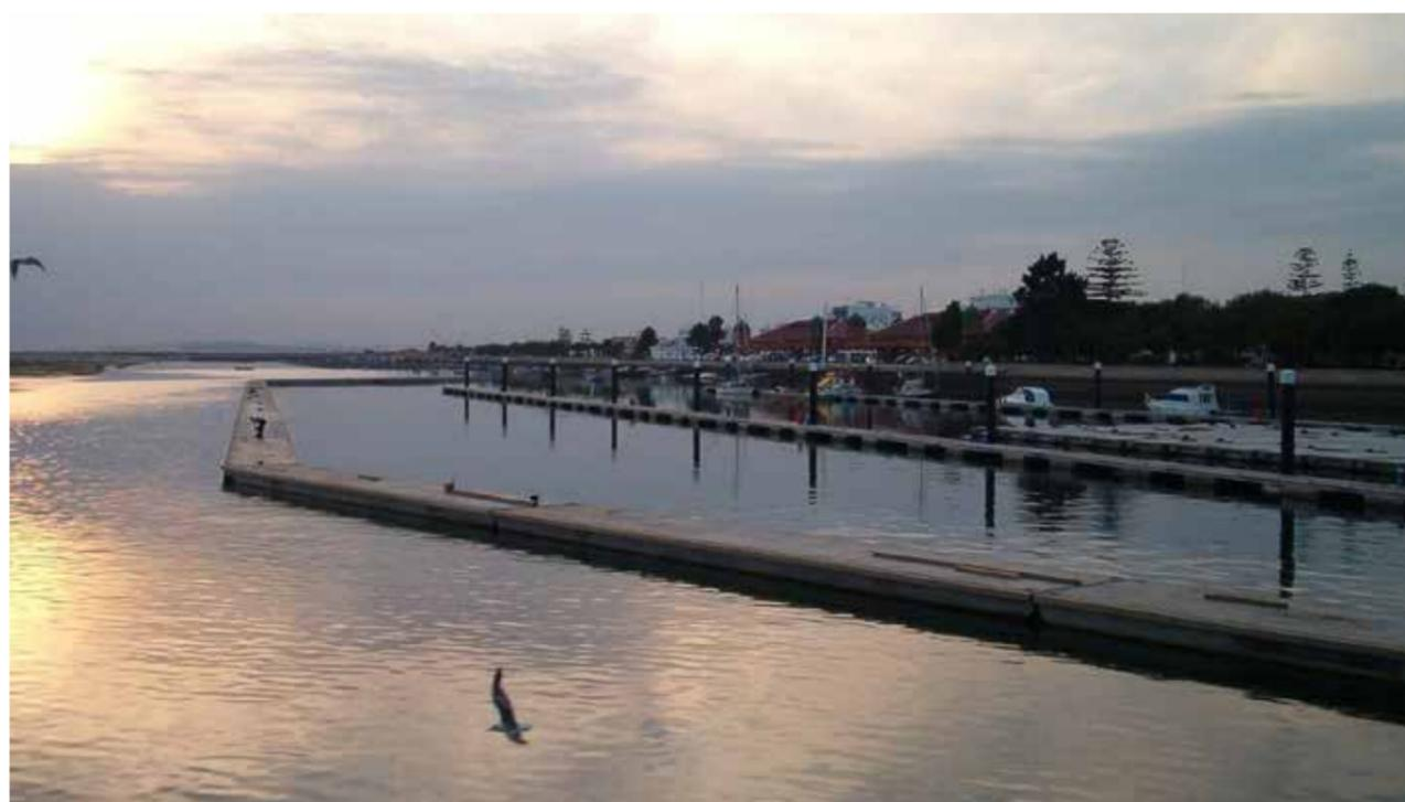
A gama QMF (Quebra-Mar Flutuante) é constituída por pontões robustos, resistentes e seguros, em betão reforçado com núcleo de poliestireno expandido.
