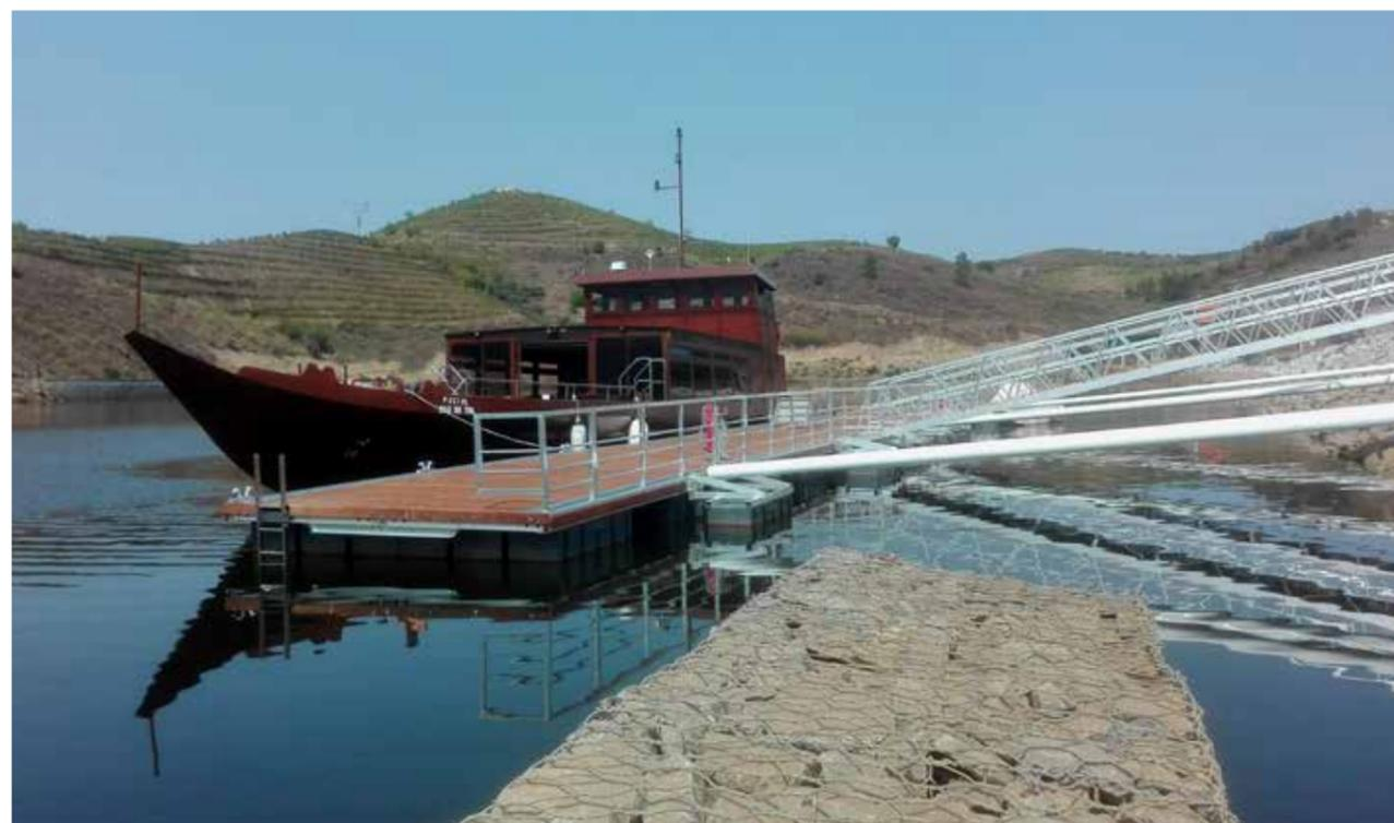
O sistema Faro HD é constituído por equipamento flutuante com estrutura reforçada em liga de alumínio marítimo, tem como aplicação a acostagem e amarração de embarcações em bacias semi-abrigadas em locais agressivos e onde a corrosão seja um factor crítico.
