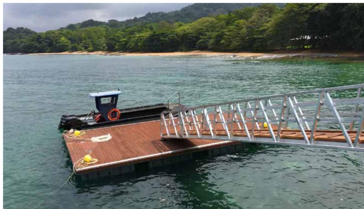
Los sistemas Faro y Faro+ están formados por pantalanes flotantes con una estructura con perfil especial de aleación de aluminio compuesto por unidades modulares.
