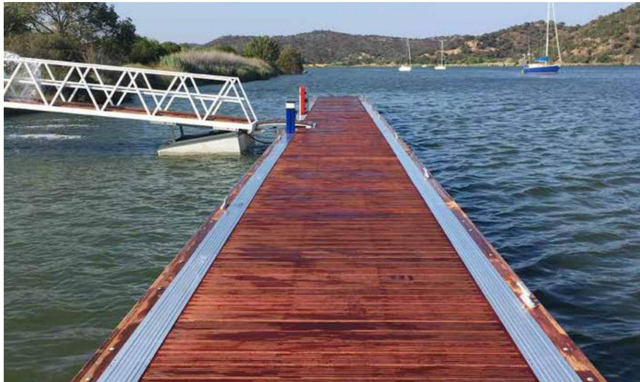
El sistema Sagres HD está formado por pantalanes flotantes con estructura reforzada con alta resistencia y capacidad de sobrecarga, disponible en varias dimensiones y francobordos, con acabados según las gamas PFC, Sagres y Faro. Los pantalanes se suministran con conductos en ambos lados, cubiertos por tapas de aluminio anodizado.
