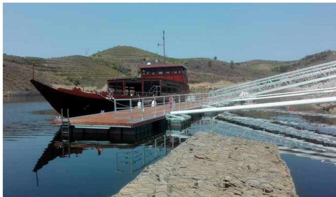
El sistema Faro HD está formado por equipamiento flotante con estructura reforzada con aleación de aluminio marítimo. Se utiliza para el amarre de embarcaciones en dársenas semiprotectidas en zonas agresivas donde la corrosión es un factor crítico.
