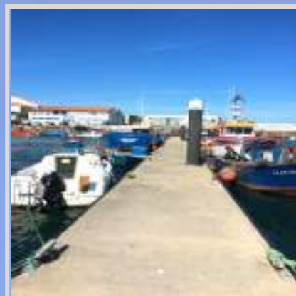
Pontons en Béton
