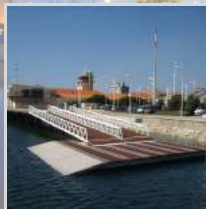
Passerelles d'Accès et Rampes
