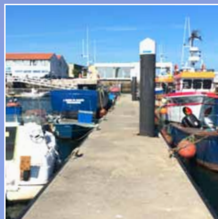
Pontões em Betão
