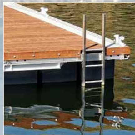
Escadas de Emergência
