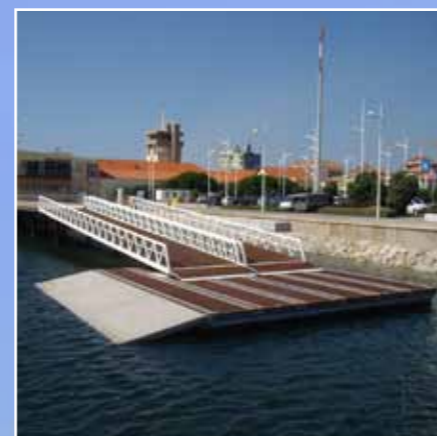
Rampas e Pontes de Acesso
